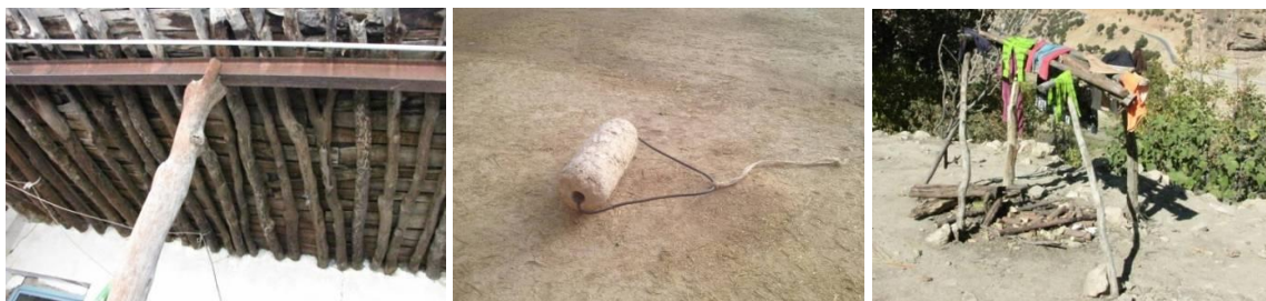
شکل ۸. استفاده از چوب بلوط در تولید دارهای چوبی سقف خانه‌های قدیمی (چپ)؛ غلتک دستی برای تسطیح بام منازل قدیمی (وسط)؛ رخت‌آویز چوبی (راست)
