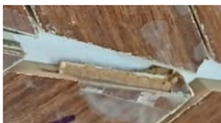
قلیف تخته چند لا با چسب PU بدون پیچ
